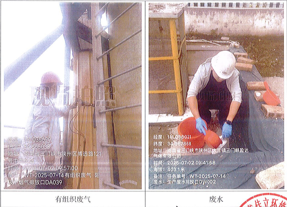
附图 现场检测照片
